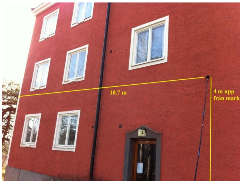
Position 4: mikrofonen höjdes upp till 4 meter ovan mark och 10,7 meter från kortsida fasad med balkonger.
