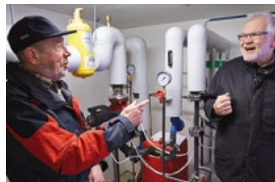
Bosse Larsson, teknisk handläggare och engagerad suppleant i styrelsen, visar undercentralen i bostadsrättsföreningens gemensamma förråd. Här växlas det heta fjärrvärmevattnet ner till 60–65 grader och skickas därefter ut till husen i området.
