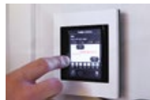
Det är lätt att ändra i systemet. Under helgen har familjen valt att sänka temperaturen vid 23.30, för att sen höjas lite senare än på vardagsmorgnar. Men med bara några knapptryckningar kan man lägga in andra tider och temperaturer.
