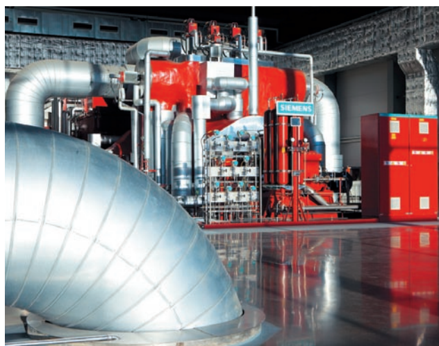
Turbinen som producerar el i Igelsta kraftvärmeverk.
