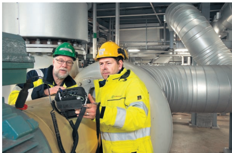
Anders Andersson, maskintekniker, och Henrik Antropov, förman FU-gruppen gör en vibrationskontroll.
