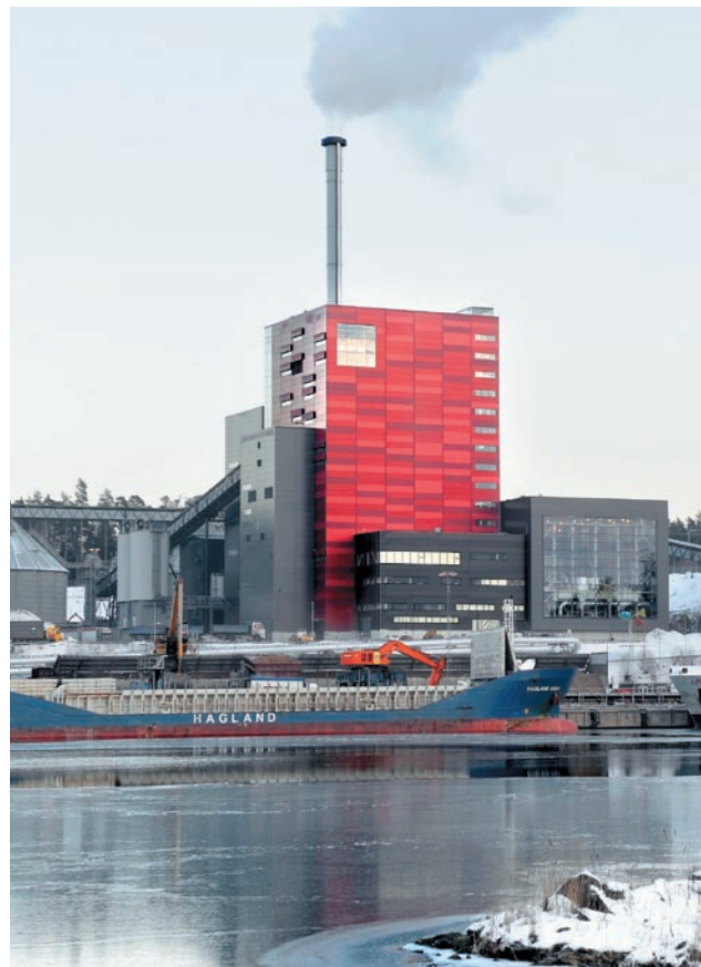
Igelsta kraftvärmeverk är Sveriges största bioeldade kraftvärmeverk.
