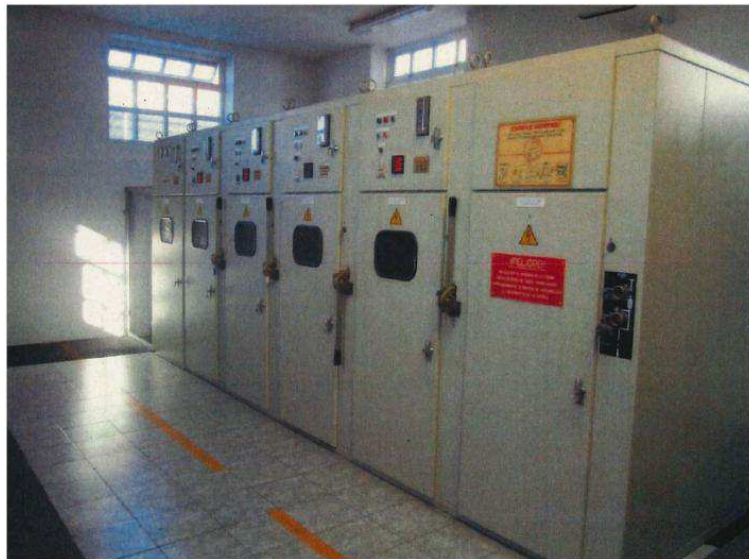
Ilustración 23. Celdas del bombeo de agua tratada de Planta 3
