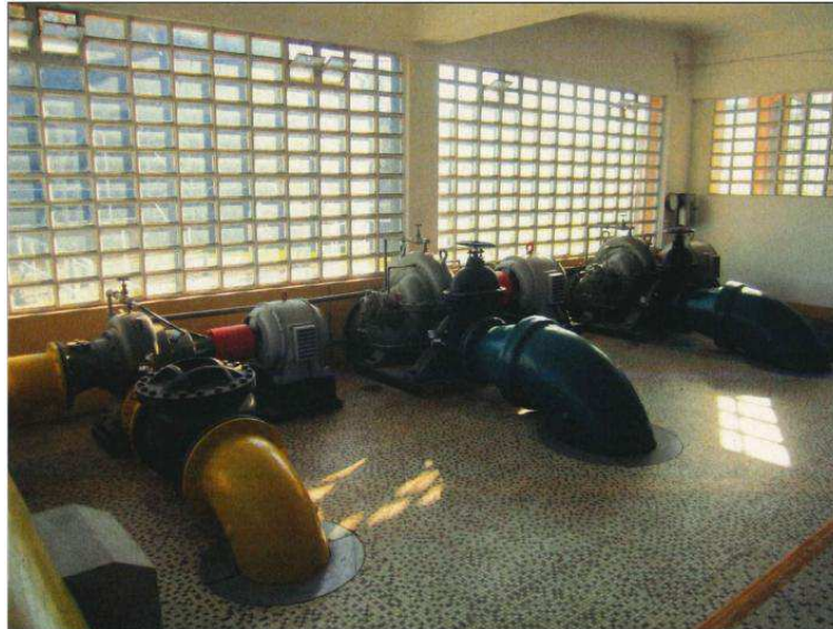
Ilustración 4. Bombas de agua bruta y lavado de Planta 1
