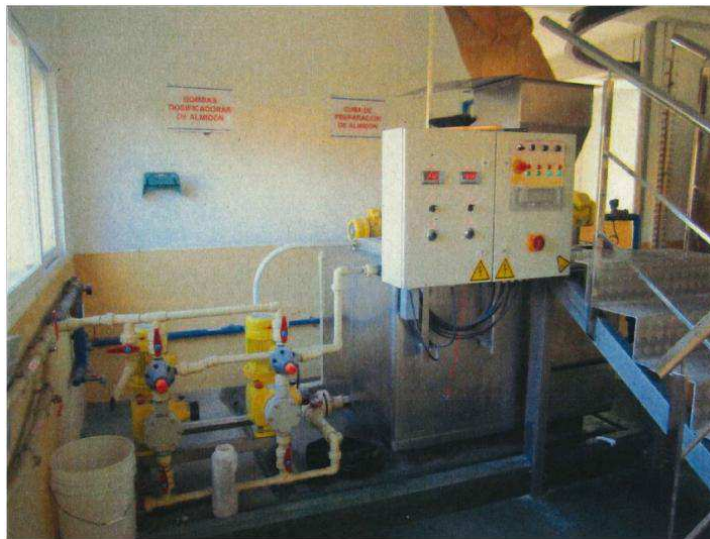
Ilustración 7. Unidad de preparación de Almidón
