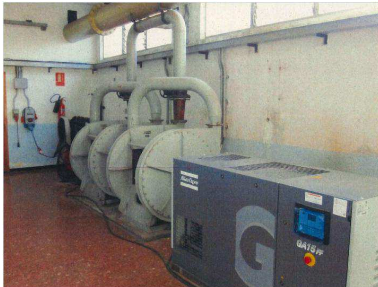
Ilustración 13. Compresor de Planta 2
