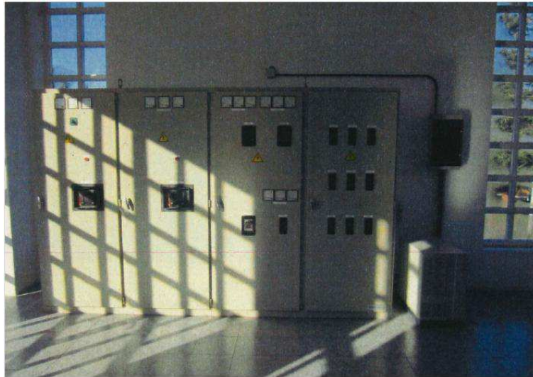
Ilustración 24. Cuadro de distribución de baja tensión en el CT de Planta 3
