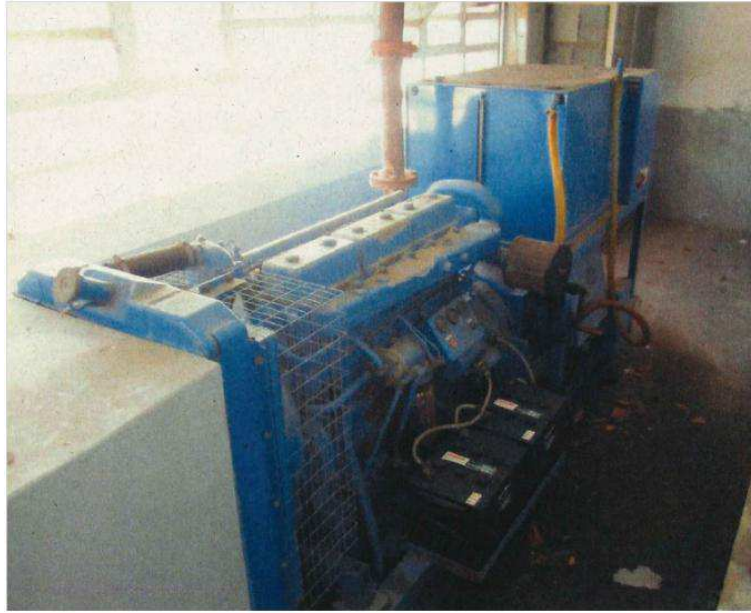
Ilustración 15. Grupo electrógeno Planta 2
