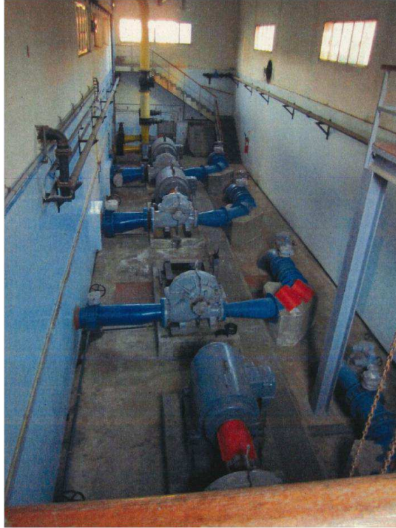
Ilustración 12. Área de bombas de agua tratada de Planta 2
