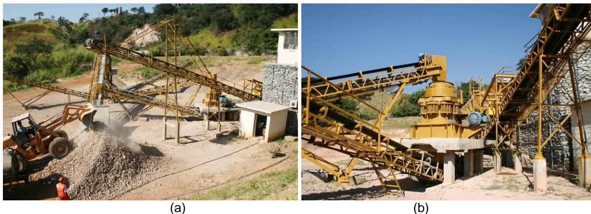
Figura 2 - Unidade de Reciclagem de Resíduos de Construção e Demolição
