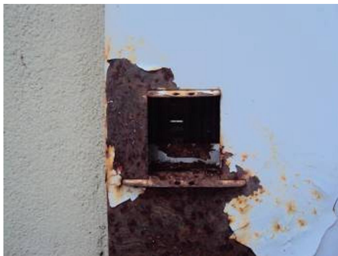
Foto 5: Condições precárias das instalações
