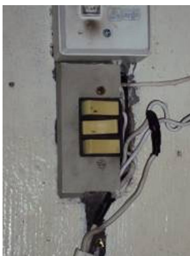
Figura 7: Cabos mal isolados e instalados em caixa de passagem.
