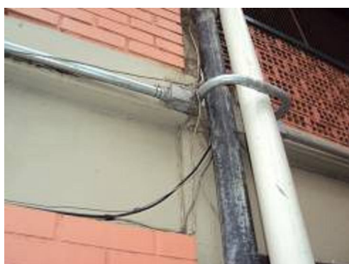
Figura 2: Emendas mal feitas e cabos fora dos eletrodutos.
