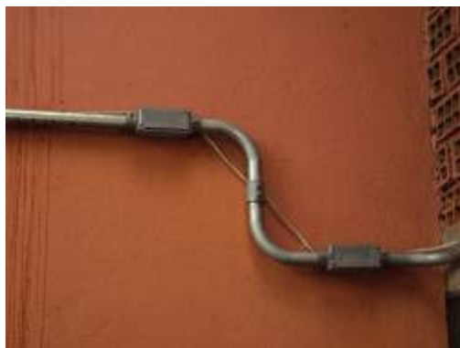
Figura 1: Cabo passando atrás do eletroduto.
