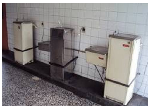
Figura 3: Tomadas dos bebedouros pátio.
