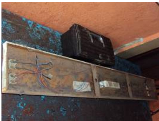
Figura 6: Parte interna de uma luminária.
