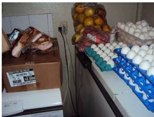
Figura 8: Aparelhos de refrigeração ligados na mesma tomada.
