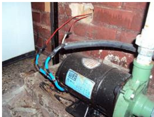
Figura 9: Instalações mal feitas na bomba d'água.
