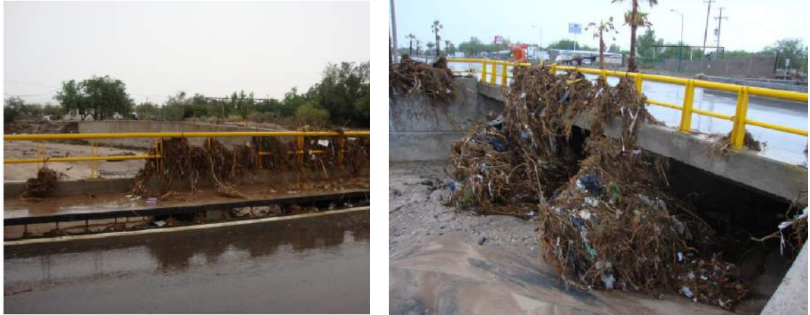
Imagen 5 y 6: Puente sobre la carretera 26 el arroyo el Buey rebasó la capacidad del puente en la lluvia del verano de 2010.
