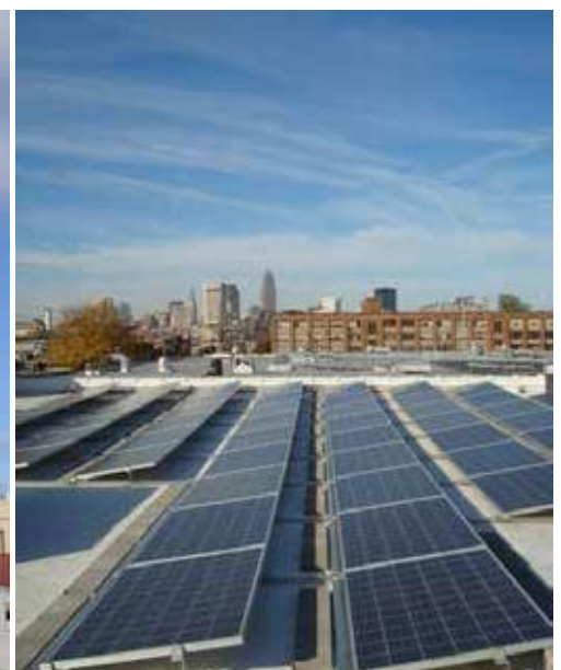
Midtown Solar Array
