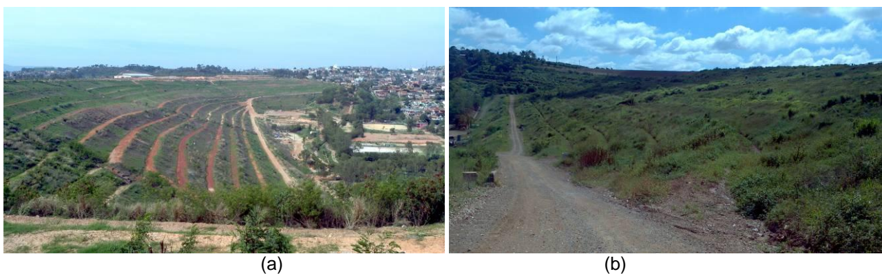
Figura 5 - Aterro Sanitário da BR 040
