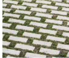
Pavage en béton avec ouvertures de drainage
