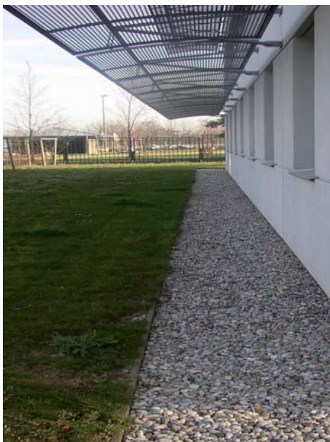
◀ Tranchée sous toit
